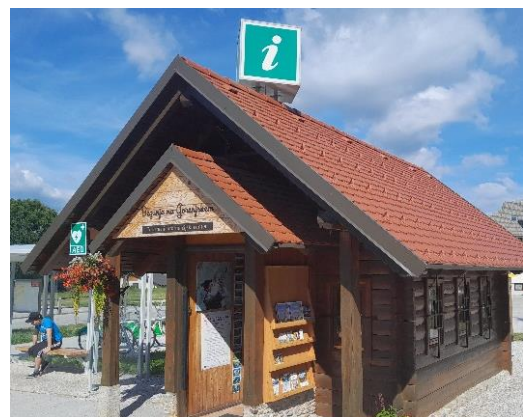
Slika 5: TIC Begunje z novim zunanjim stojalom za promocijske materiale
